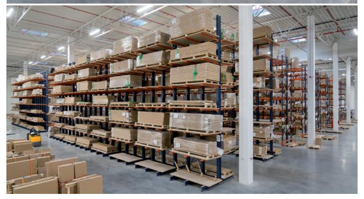
MYCS ha equipado su nuevo centro logístico de 12.748 m² en Szczecin (Polonia) con estanterías para palets y estanterías cantilever de Mecalux. Las dos soluciones de almacenaje sobresalen por su flexibilidad, al poder ajustarse a las dimensiones y volúmenes de los productos (componentes para muebles como mesas, estanterías o armarios). Además, al ofrecer acceso directo a la mercancía, agilizan la gestión de las cargas y ayudan a controlar el stock.
